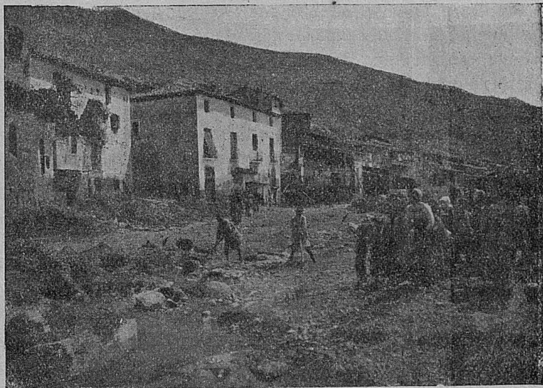
1-1 Huertos de Torrijo, destruidos por las avenidas del barranco del Val y del río Manubles. 2 Casa de la misma villa destruída por estos cursos de agua
