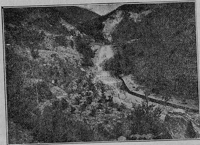
Dique curvilíneo hidráulico núm. 3, de 9'20 metros de altura sobre cimientos con su zampado y contradique y un trozo de encauzamiento empedrado entre los diques de primer orden, números 2 y 3.
