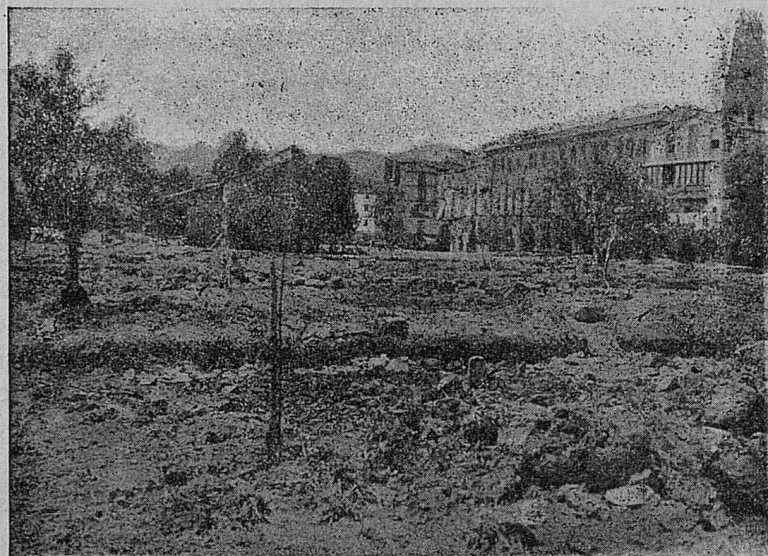
1-1 Huertos de las proximidades de Ateca destruidos por el río Manubles; las tapias que los cercaban fueron derribadas en su totalidad.
