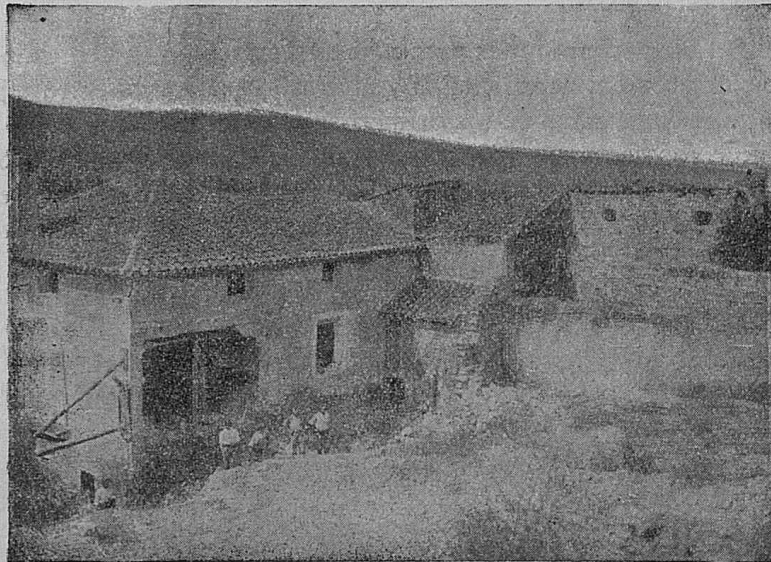
Casa del pueblo de Manchones destruída en 1908 por el torrentillo «El Sebo» después de tirar la tapia del corral de la misma.
