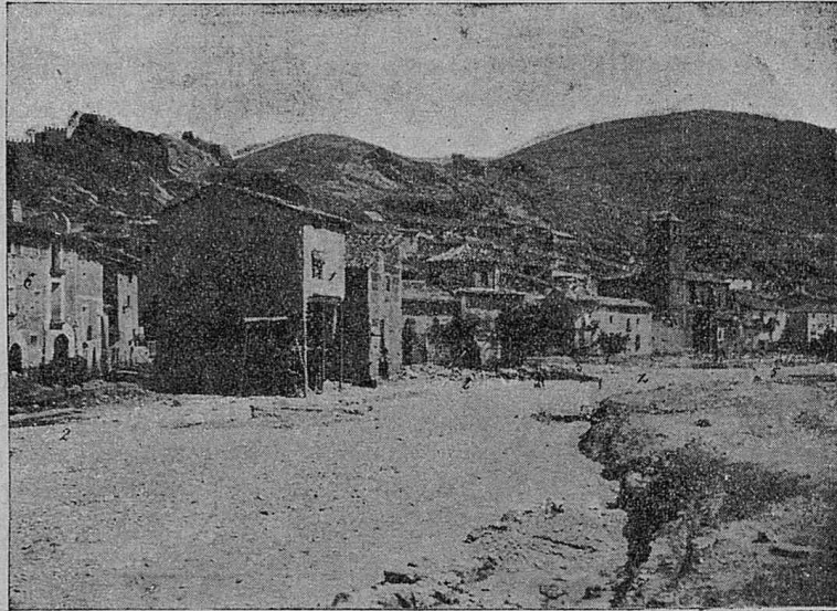
Casas 1-1 y huertos 2-2 destruidos por el barranco del Val en Torrijo. 3 Sacristía de la iglesia de la Purísima destruída por este torrente. 4 Desembocadura del barranco del Val en el río Manubles 5-5. 6 Casas en ruína inminente ocasionada por el barranco del Val.
