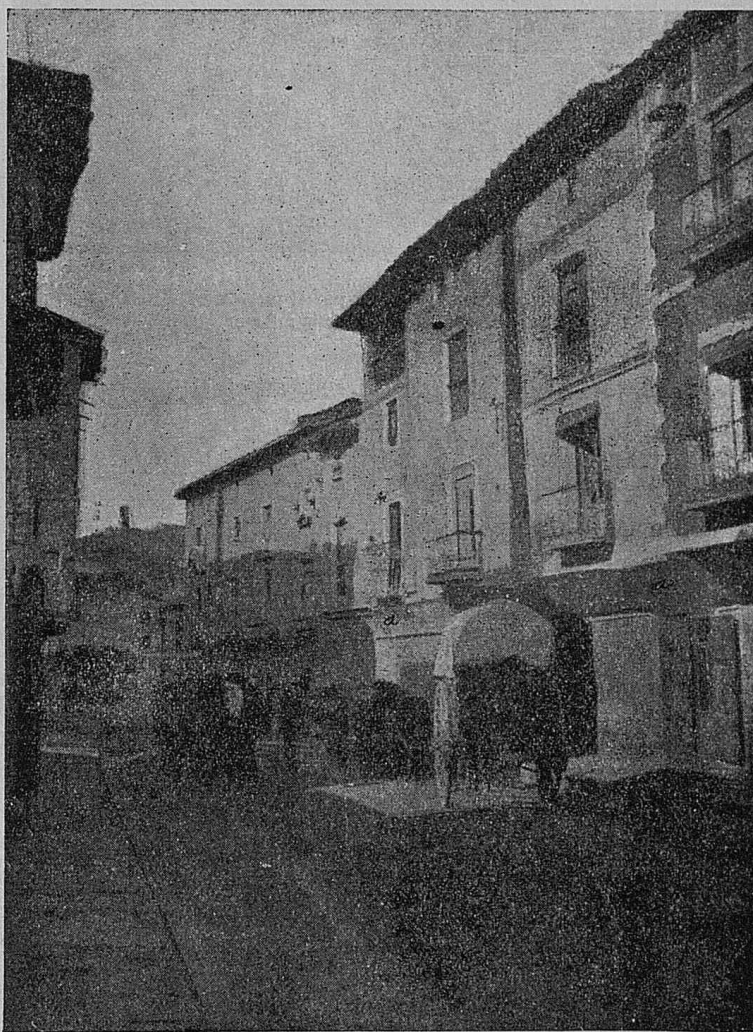
a. Nivel del agua de la avenida de 1870, del torrente «Rambla de la Mina» en una casa de la calle Mayor de Daroca.
