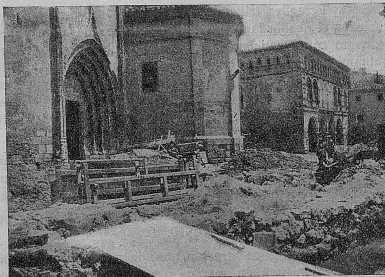
Iglesia parroquial inundada y entarquinada por las avenidas del río Manubles. 1-1 Nivel del agua en la fachada principal. 2-2 Bancos, confesionarios y otros objetos del culto arrastrados por las aguas. 3 Tarquín y piedras depositadas en la calle de la carretera de Torrijo; algunos de estos productos fueron sacados de esta iglesia.
