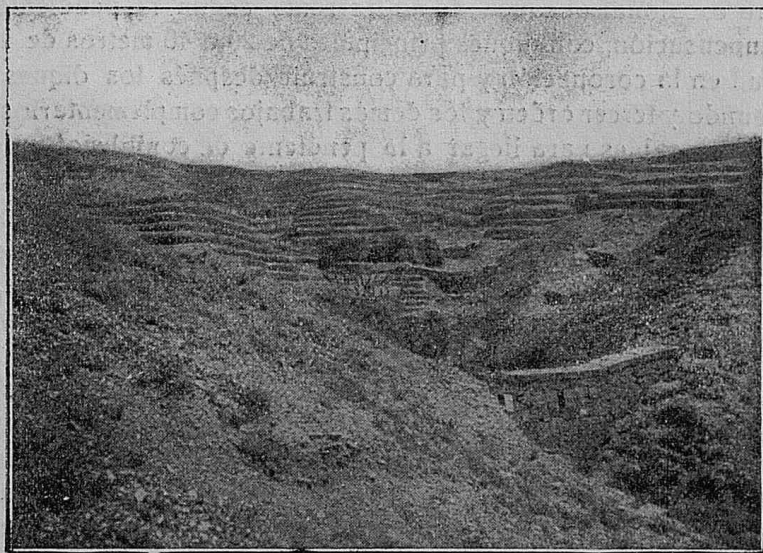
La misma erosión después de descrestada y abancalada por diquecillos de piedra a-a y estacadas. b-b. c-c Dique base de la corrección de esta concha.
